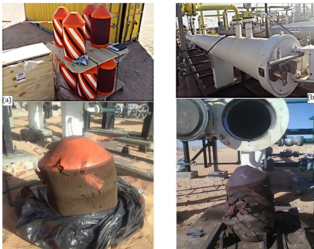
Hình 16. Hình ảnh trước và sau phóng thoi. (a) Foam Pig đang sử dụng; (b) Thiết bị phóng Pig của GBRs.
